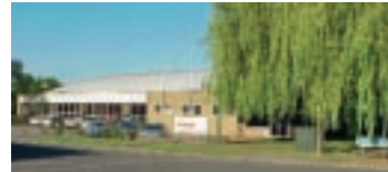
PHASA Factory and Offices PHASA-Werk und Büros
